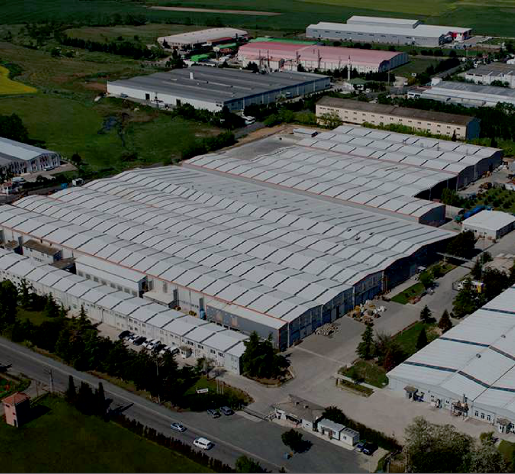
Termo Teknik Çorlu Üretim Tesisleri
